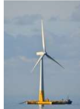
Figure 14 : Éolienne flottante « FloatGEN » au large du Croisic (©B. Guichard – OFB)
