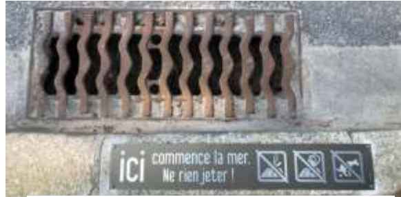
Figure 29 : Installation de plaques de sensibilisation près des grilles d'eaux pluviales (©Cap Atlantique)
